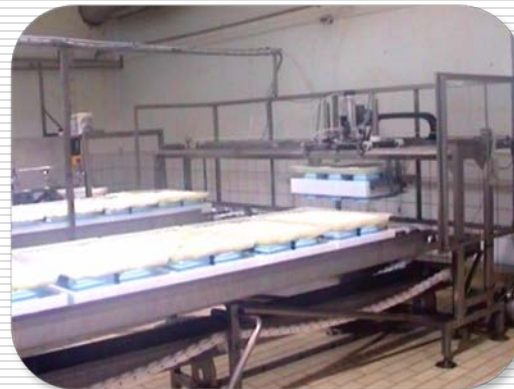
Τα καλούπια στο μεταφορέα
