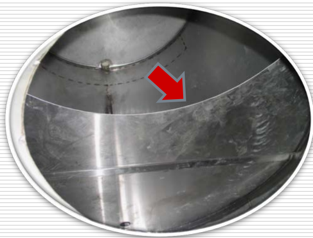
Ενδιάμεσα τοποθετούνται αντιπαφλασμικά διαχωριστικά
